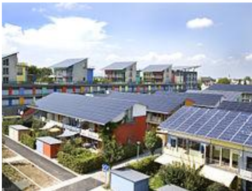
Figura 3 – Painéis fotovoltaicos em moradias de Friburgo (Alemanha)
